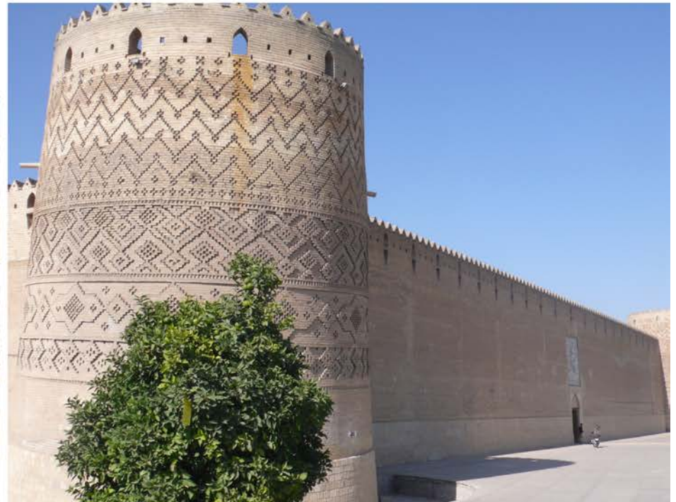
Festungsmauer mit krummen Türmen
